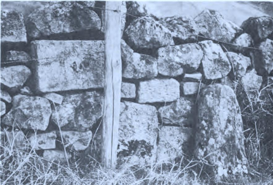
Foto 11. — Detalle de la pared en la que se aprecian piedras perfectamente labradas.
