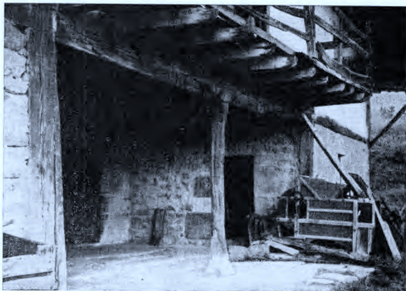
Foto 23. — Viga de madera con basa de piedra «Mendigune».
