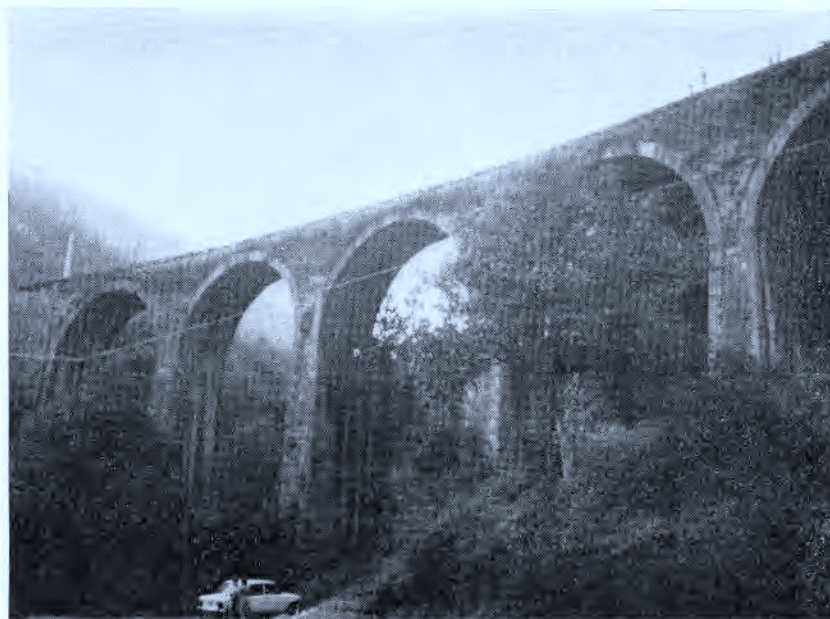
Foto 46. — Puente de piedra del forrocarril Amorebieta-Bermeo.
