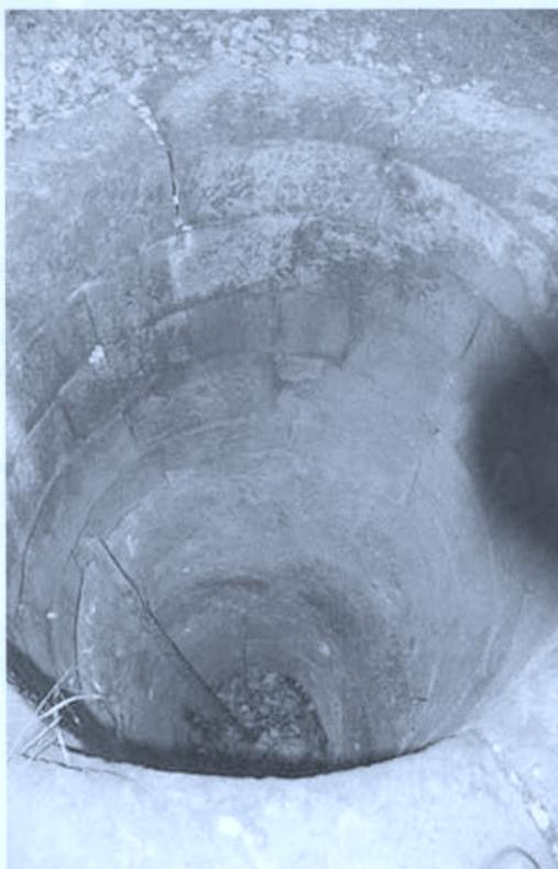
Boca superior de carga. Se aprecia la parte excavada en el terreno y la de sillaría.
